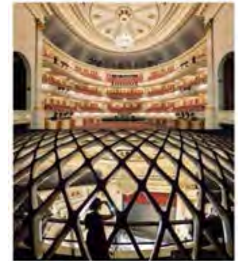
Nachhall-Galerie der Berliner Staatsoper „Unter den Eichen“ aus glasfaserverstärkter Phosphat-Keramik erfüllt höchste Brandschutzanforderungen (A1)
